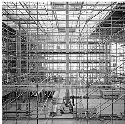
HdAeNo Gerüst IV
